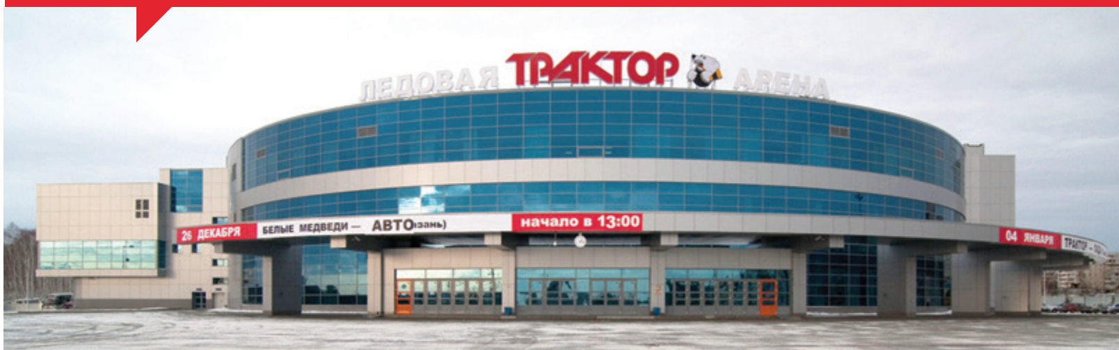
Ледовая арена, г. Челябинск
