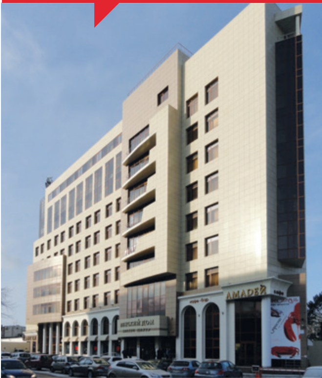
Офисное здание, г. Краснодар
